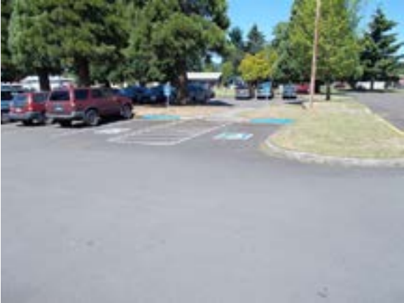
Figure E10.4 – Sidewalks
