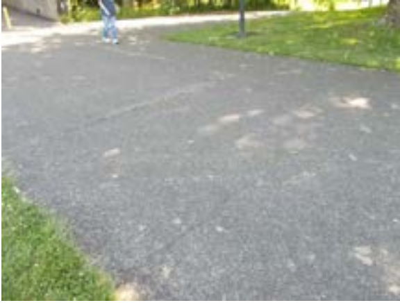
Figure E10.4.a – Sidewalks
