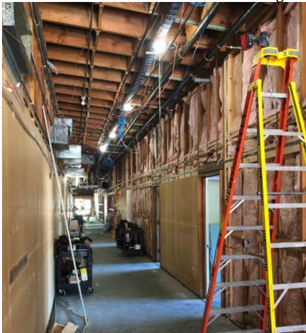
Trabajo en el techo del corredor oeste, incluyendo bloqueo sísmico, tuberías y electricidad.
