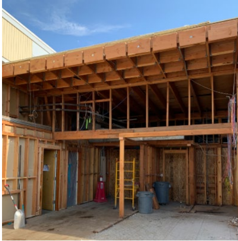
Antigua oficina lista para la estructura del techo nuevo
