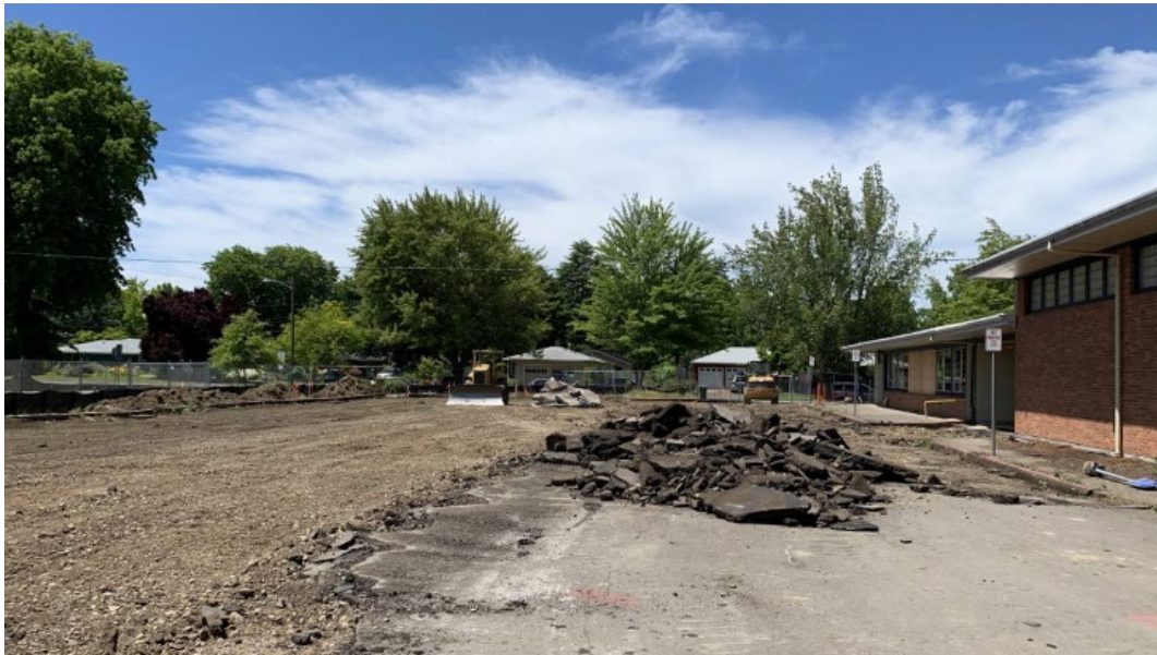
Estacionamiento Oeste bajo construcción
